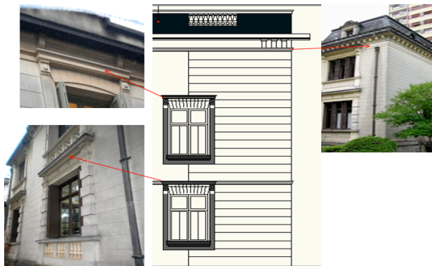
Figura 17 – À esquerda, detalhe das molduras utilizadas na fachada da “ Casa das Rosas”, ao centro o mesmo elemento sendo empregado no projeto de GUARNIERI, (2012). E a direita um exemplo da moldura novamente presente na “ Casa das Rosas ” – SP de Ramos de Azevedo. Fonte:GUARNIERI,(2012).
