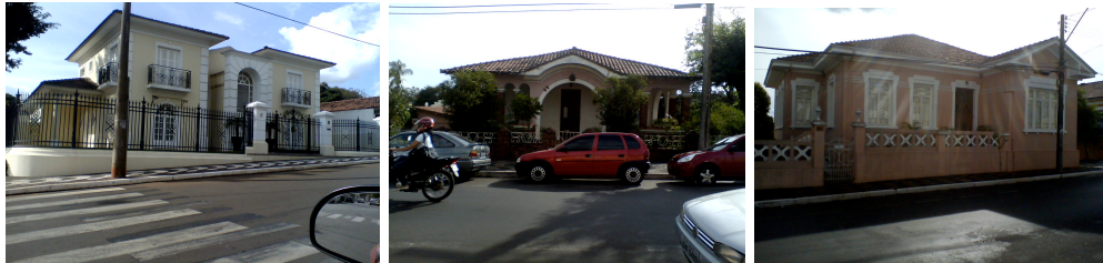
Foto 01,02 e 03 – Fachada das casas do cento histórico de Brotas/SP Fonte: GUARNIERI (2012).
