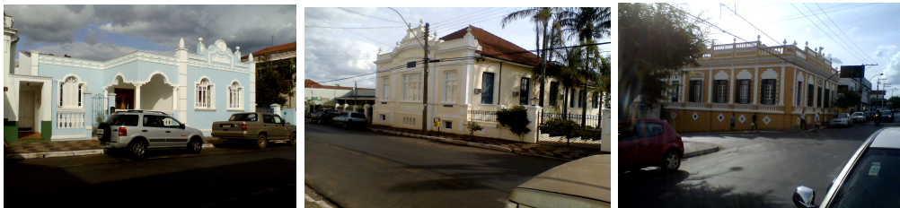
Foto 04,05 e 06. – Fachada das casas do cento histórico de Brotas/SP Fonte: GUARNIERI (2012).
