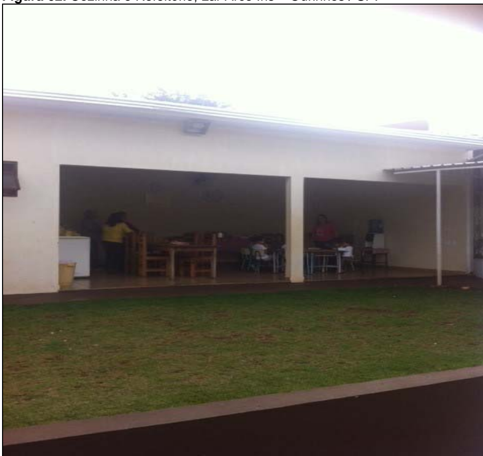
Figura 02. Cozinha e Refeitório, Lar Arco Íris – Ourinhos / SP.
