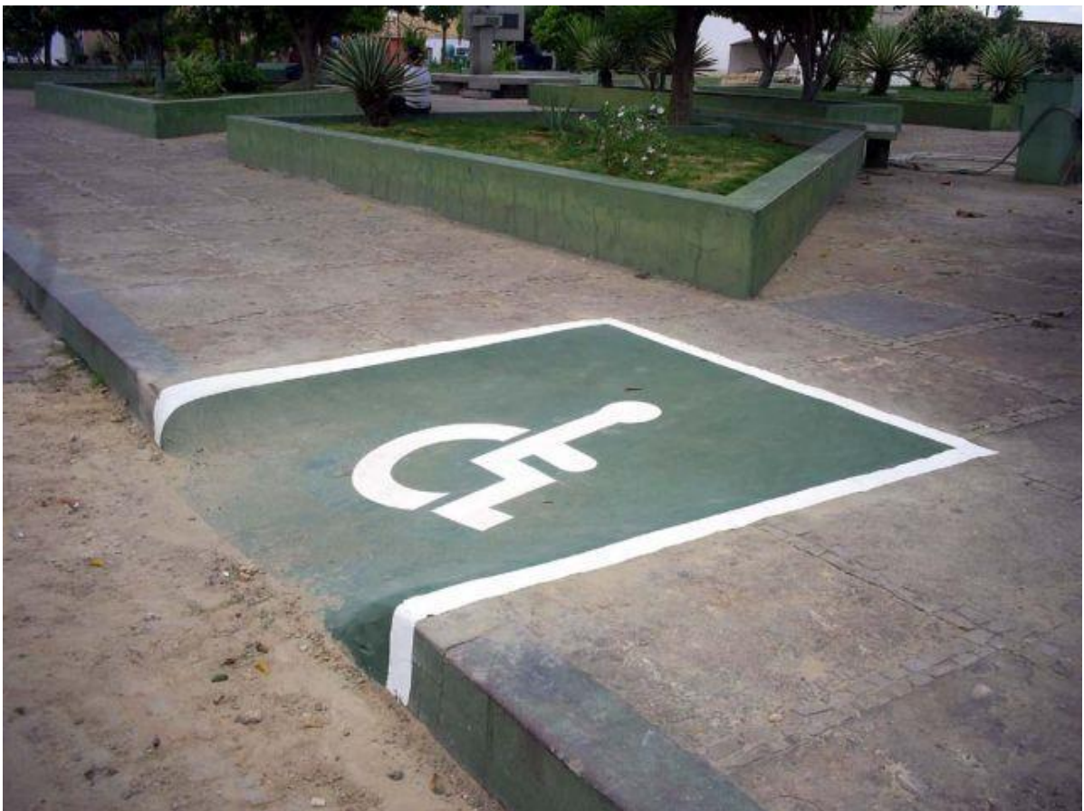
Figura 02: Rampa para deficientes físicos.
