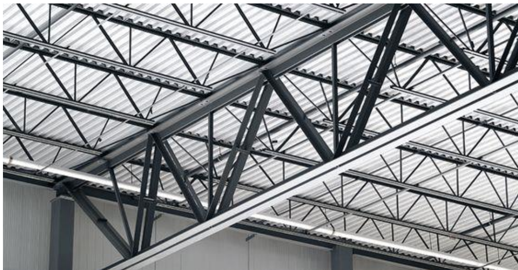
Figura 3- Estrutura Metálica usada em construção civil.
