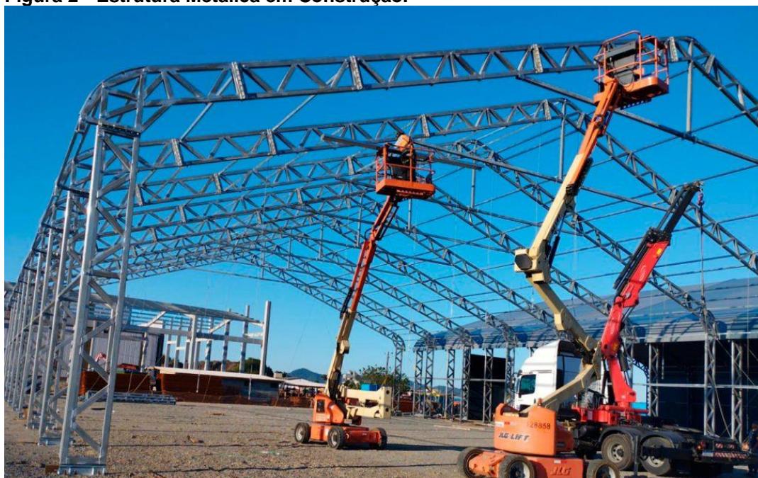
Figura 2 - Estrutura Metálica em Construção.
