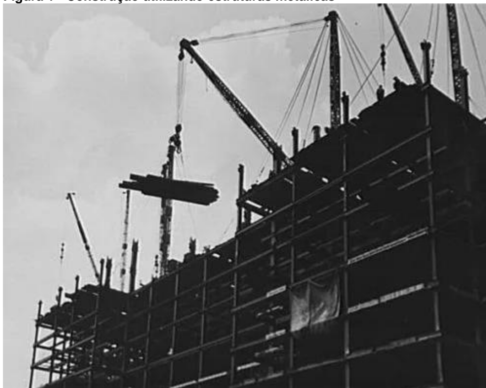
Figura 1 - Construção utilizando estruturas metálicas
