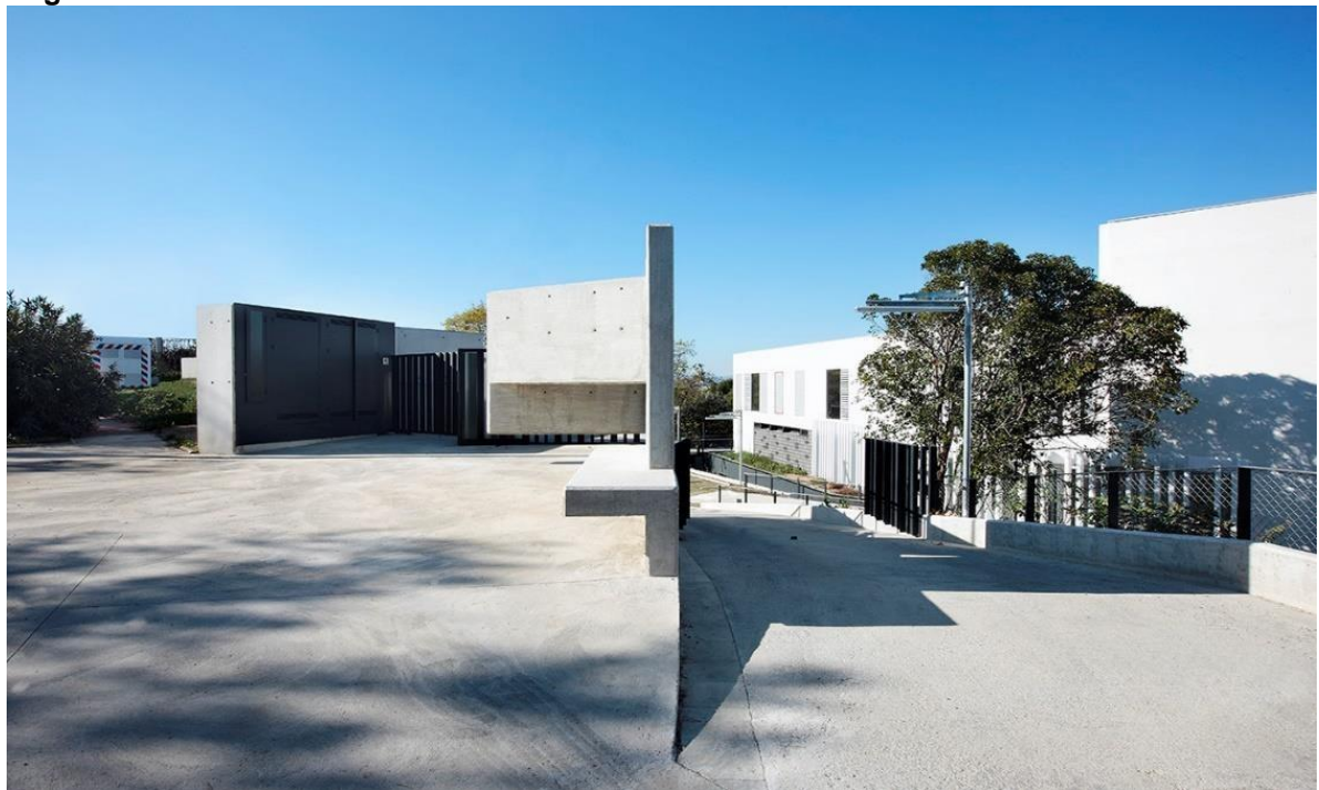
Figura 01. Fachada Frontal da Residência e Centro DIA.
