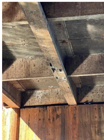
Figura 9 – Apoio “seco” sem aparelho de apoio
