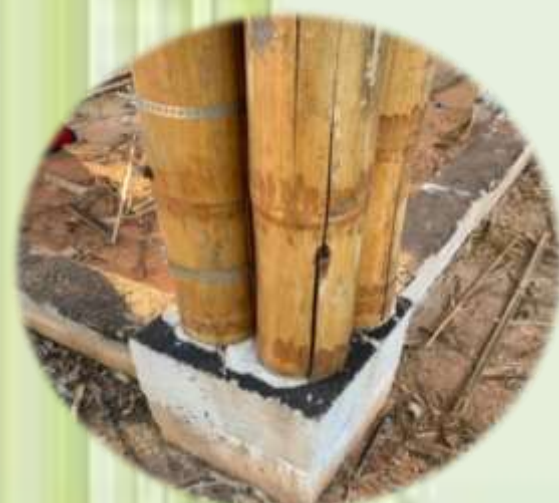
Figura 01: Fundação de concreto ligado a estrutura de bambu Dutra e Ludwig (2019), acesso em Setembro de 2021.
